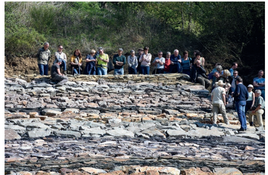
Fig. 44 - Une visite lors de la pose du grès famennien (couleur ocre au sommet de la construction).
