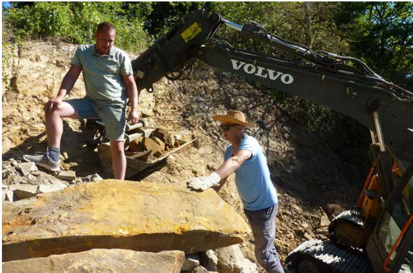
Fig. 35 - Paolo et le grutier Julien à la pose du grès ferrugineux diestien.
