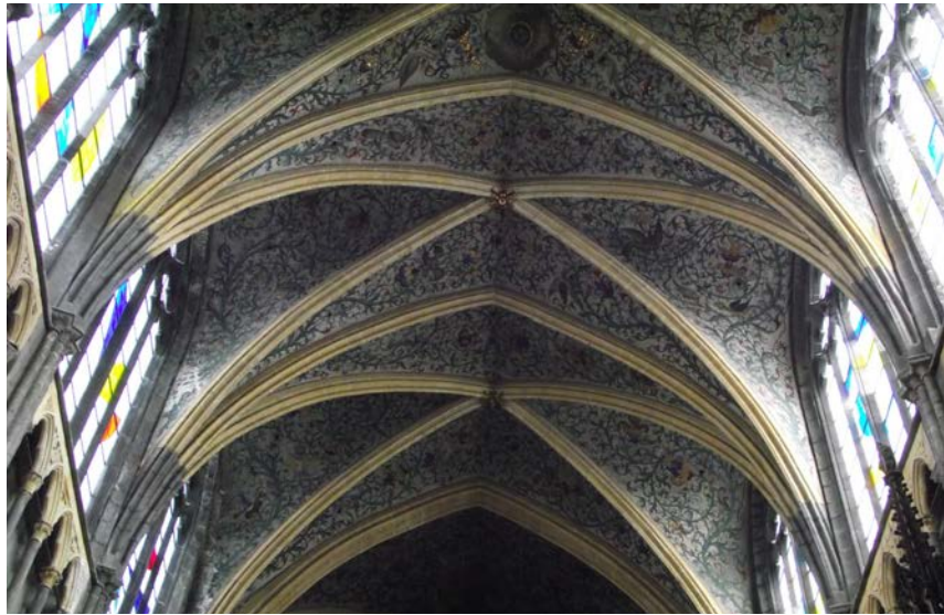
Fig. 22 - Les voûtes de la cathédrale Saint-Paul à Liège. Les nervures sont en calcaire bajocien de Dom-le-Mesnil.
