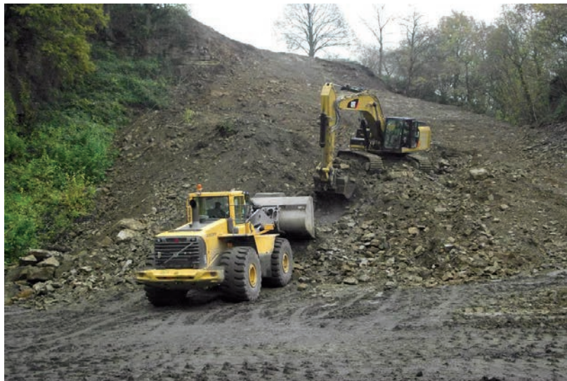
Fig. 3 - L'attaque du chantier.
