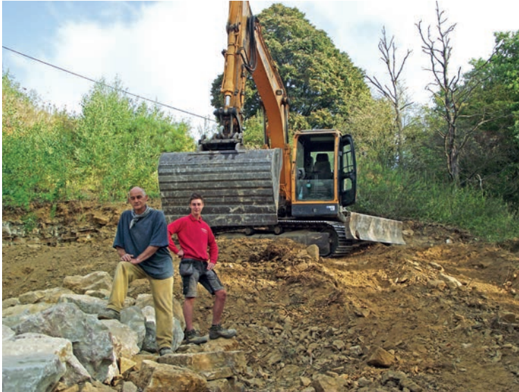
Fig. 17.- Paolo, responsable du chantier, et Ugo, un machiniste.
